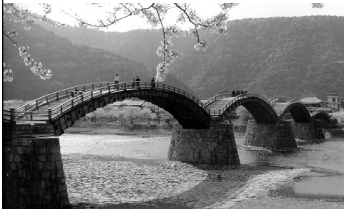
-drveni pješački most Kintai
